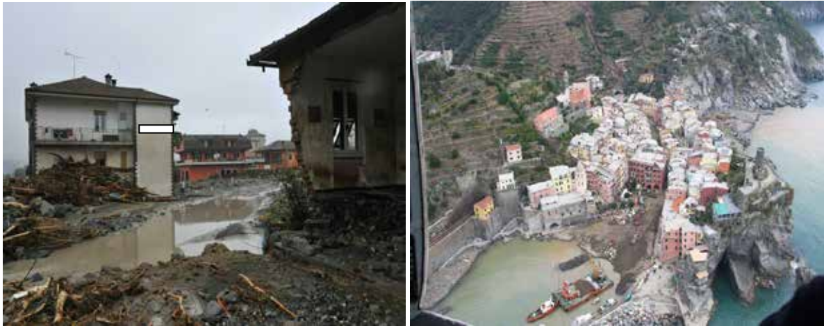
Photos 1 et 2 : Effets au sol de l'inondation de Val Vara-Cinque Terre ; A gauche : Centre-ville de Borghetto Vara (on note le niveau de l'eau durant la crue sur la maison de gauche – indiqué par un trait blanc (cliché Fazzini) ; A droite : Vue aérienne de la ville de Vernazza (Cinqueterre) ; on note la complexité orographique et l'accumulation d'environ cinq mètres de débris dans la zone portuaire (source région Ligurie).
